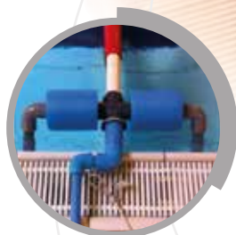
Enrouleur en tube PVC sur le rebord de la piscine
